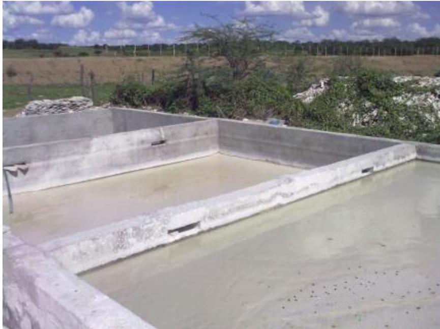
Figura 4 – Detalhes da unidade de tratamento de efluentes em uma serraria de Várzea, já em operação.
