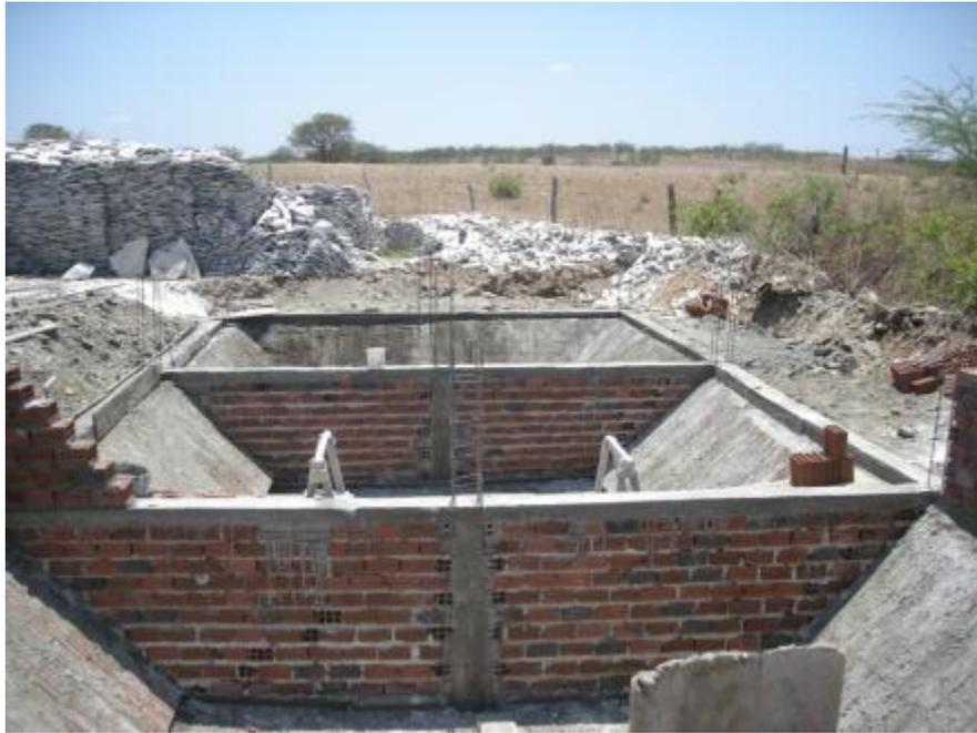
Figura 3 – Detalhes da construção dos tanques de sedimentação recomendados para o tratamento de efluentes nas serrarias de Várzea-PB. Fonte: Própria.
