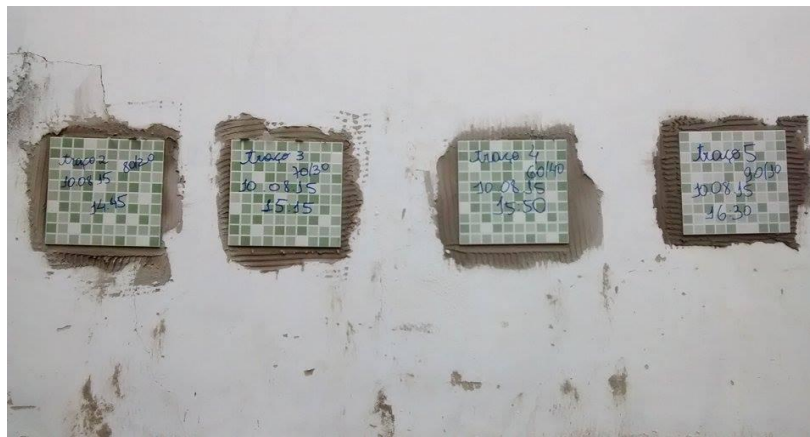
Figura 4 - Placas cerâmicas assentadas sobre uma superfície vertical no ensaio de deslizamento.
